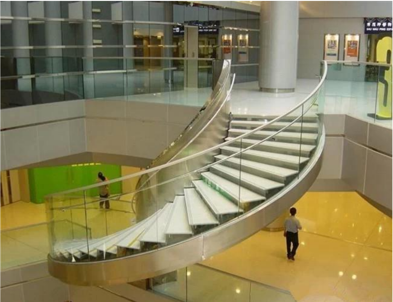
10 mm kirkas kaareva karkaistu lasi käytettiin käsijohtoon.
