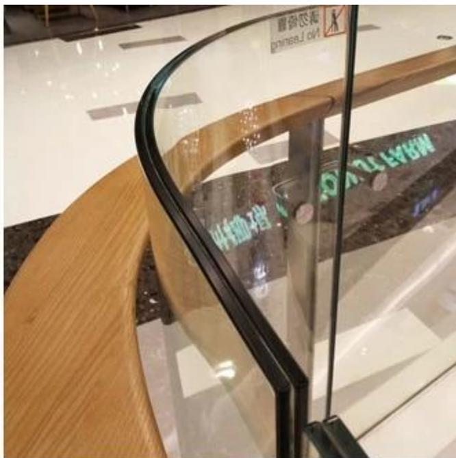
**curva de 17,52 milímetros temperado vidro laminado usado para claraboia, dossel e trilhos, etc.**
