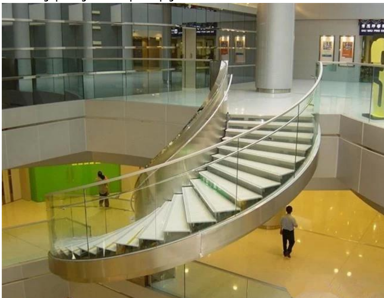
Kính cường lực cong 10mm được sử dụng cho lan can.
