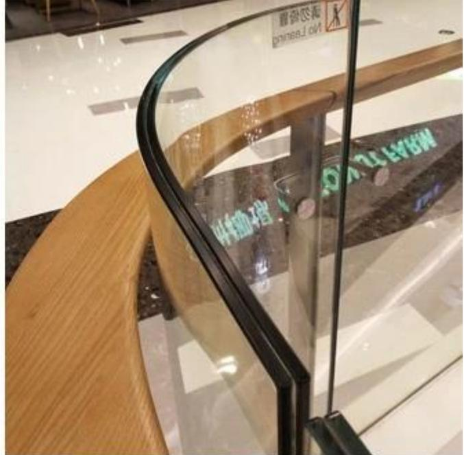
**17,52 mm Kurve temperiert Verbundglas für Dachfenster, Vordach und Geländer usw. verwendet.**
