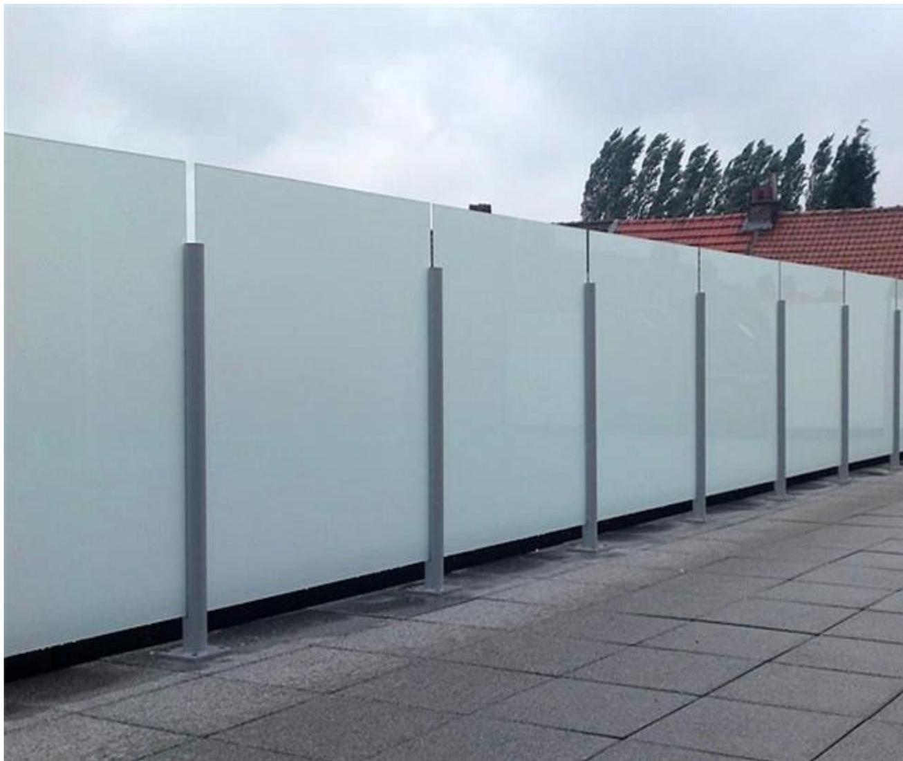
**Starkes Paket von 6mm Säure geätztem gehärtetem Glas**
