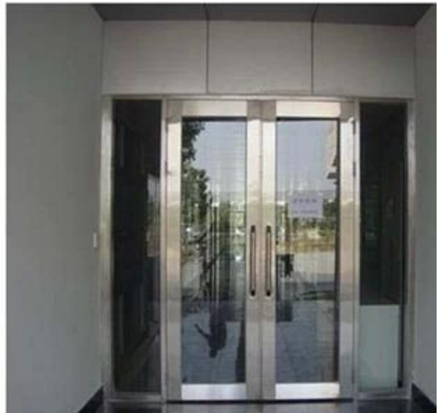
Isolierendes feuerbeständiges Glas, das für Gebäudetrennwand benutzt wird
