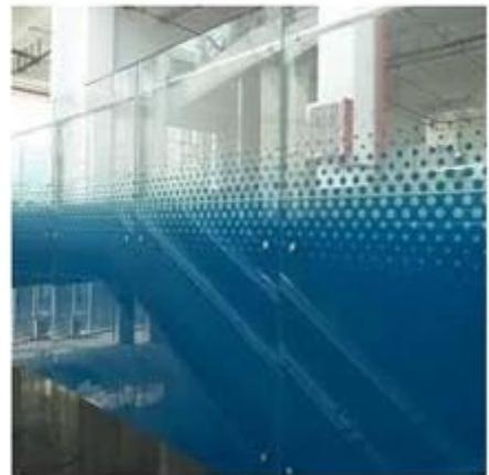
**Details des siebgedruckten gebogenen gehärteten Verbundglases für Geländerglasbalkon:**
