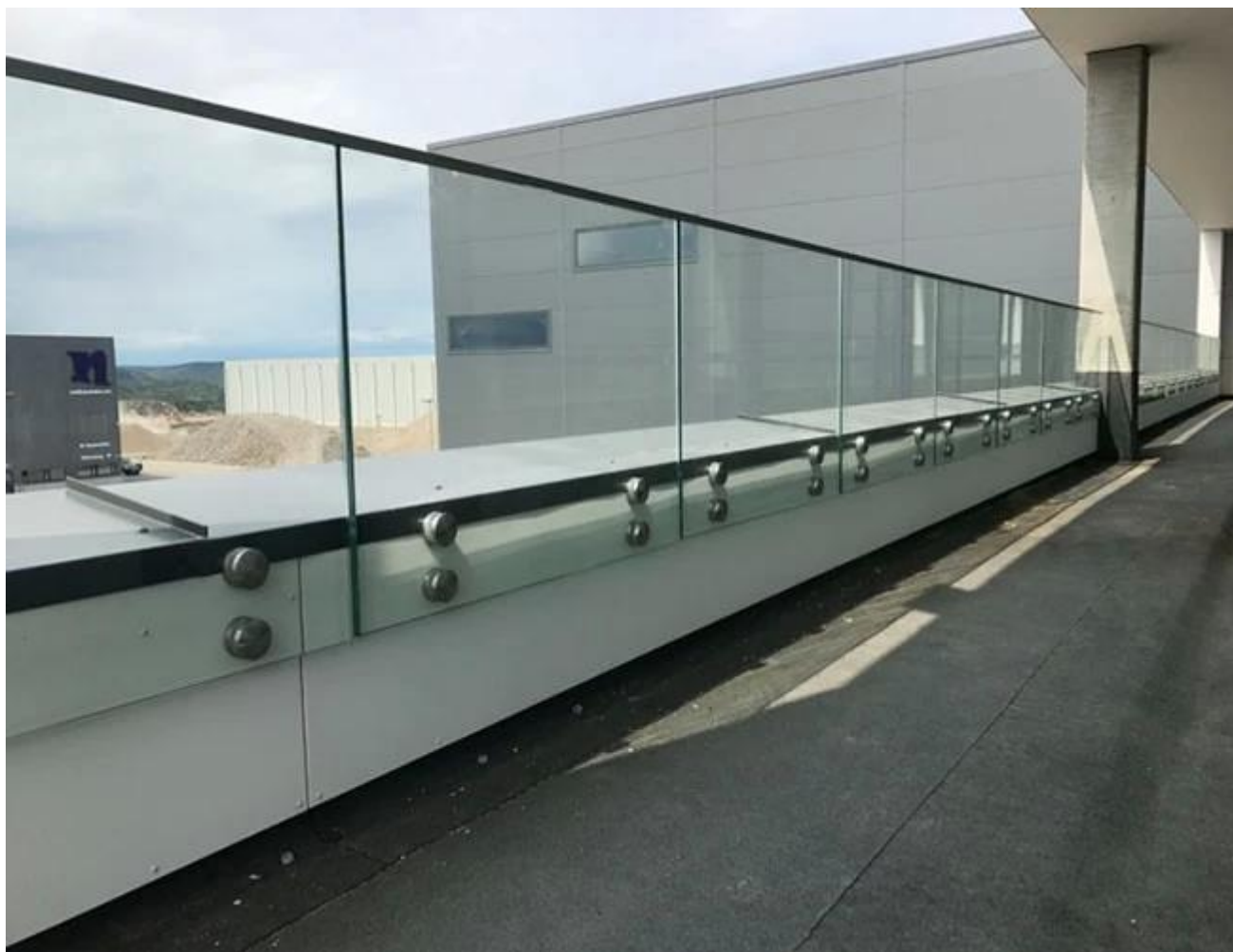
Balaustrada de vidrio laminado endurecido curado
