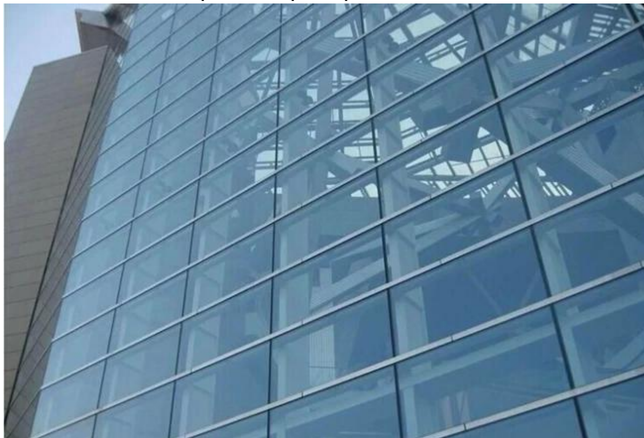
Vidrio aislado laminado templado usado para la pared de cortina:
