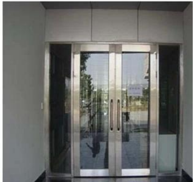
Vidrio aislante ignífugo utilizado para la partición de edificios
