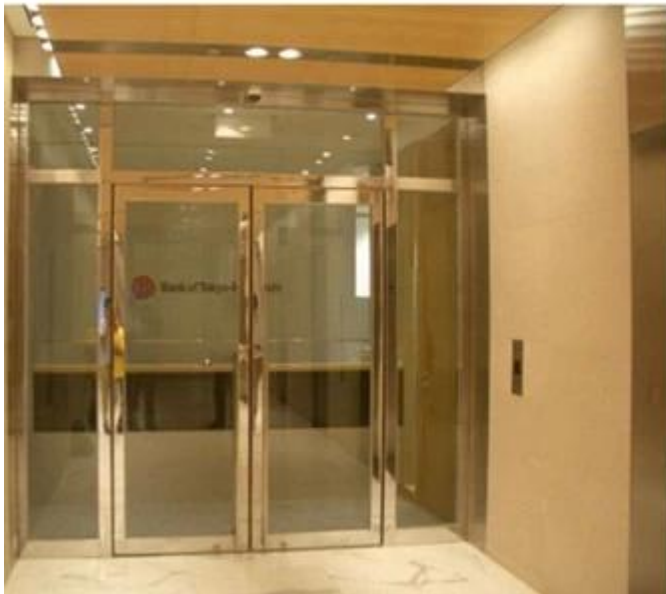
Vidrio aislante ignífugo utilizado para la partición de edificios
