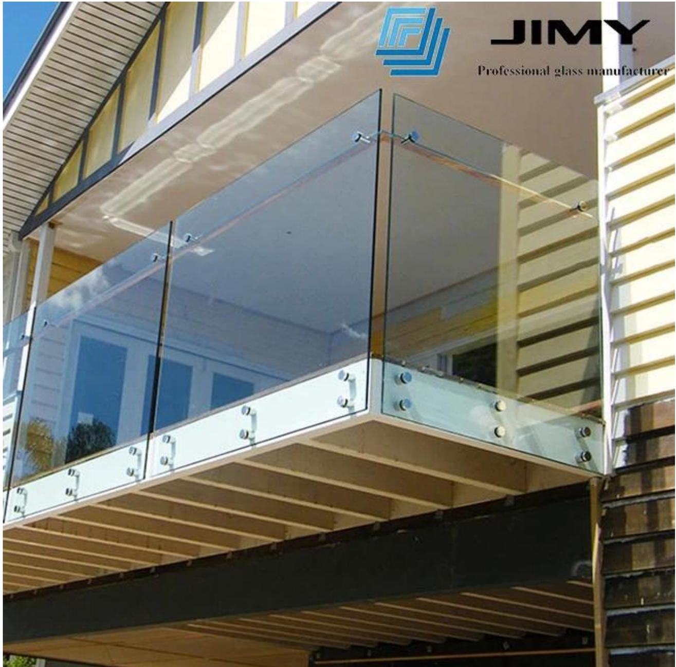
**El vidrio laminado templado transparente de 8.76 mm, también el vidrio cal led 442 esg vsg, está formado por vidrio templado de 4 mm + 0.38 mm PVB x 2 capas + 4 mm vidrio templado.**
