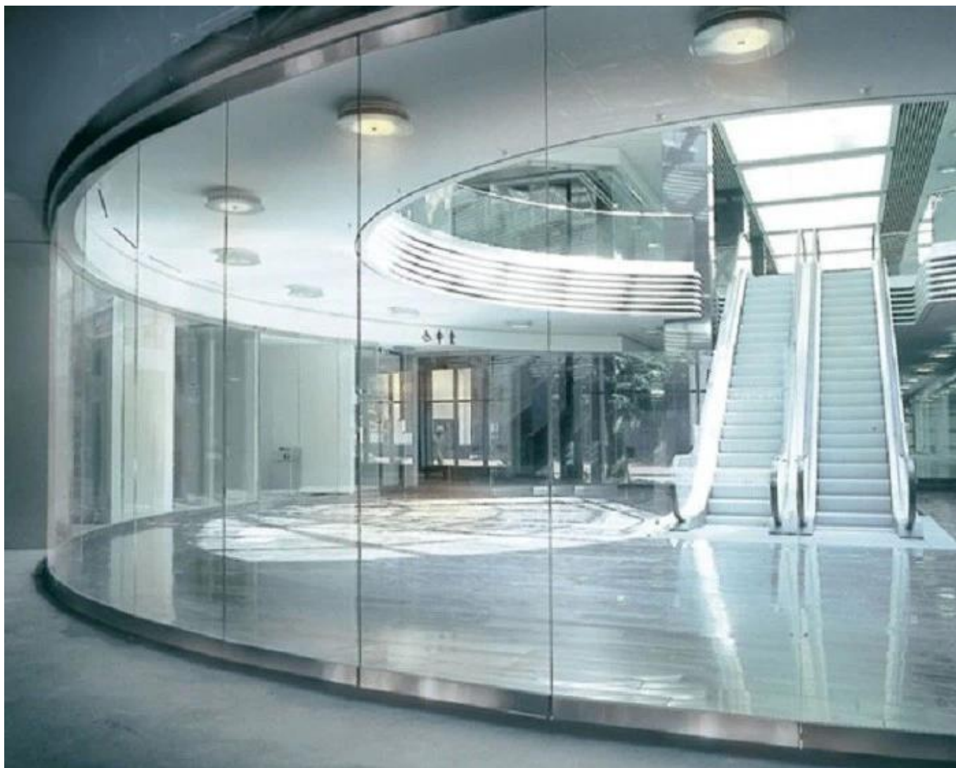
Ścianka działowa ze szkła hartowanego z nadrukiem cyfrowym 12 mm:
