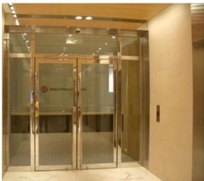
Izolacyjne szkło ognioodporne stosowane w przegrodach budynków
