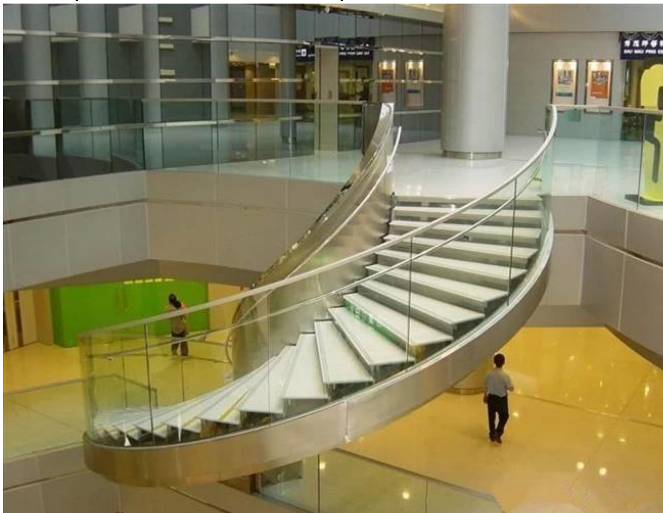
Vidro temperado curvo claro de 10 mm usado para corrimão.
