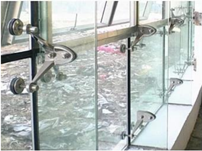
aleta de suporte de fachada de vidro laminado:
