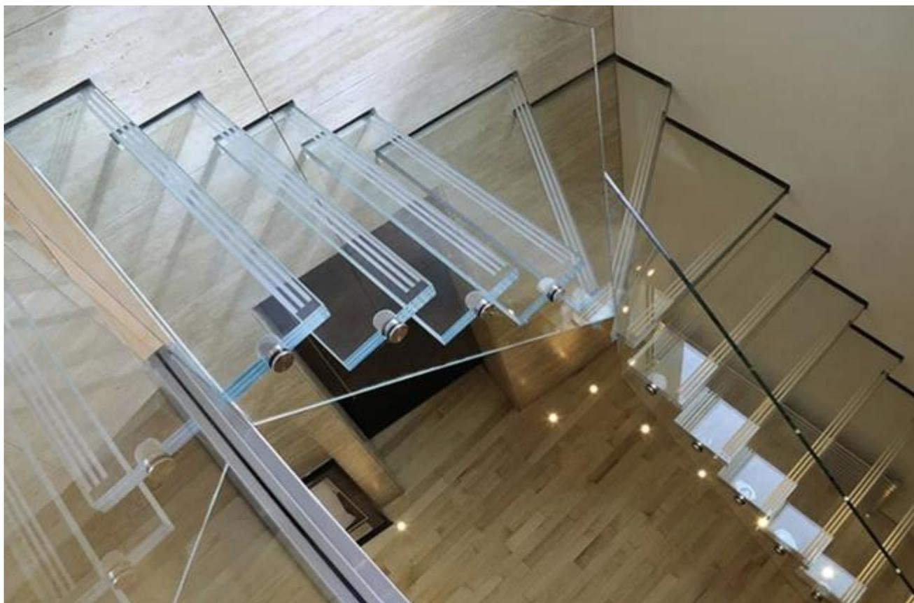
Vidro laminado em relevo processado especial, é o vidro de escada de escada de segurança mais não-escorregadio, podemos produzir qualquer copo de padrão convexo. Por causa do modo de processamento especial, o custo desse vidro de passo tipo é muito maior do que outro tipo de vidro da passarela.
