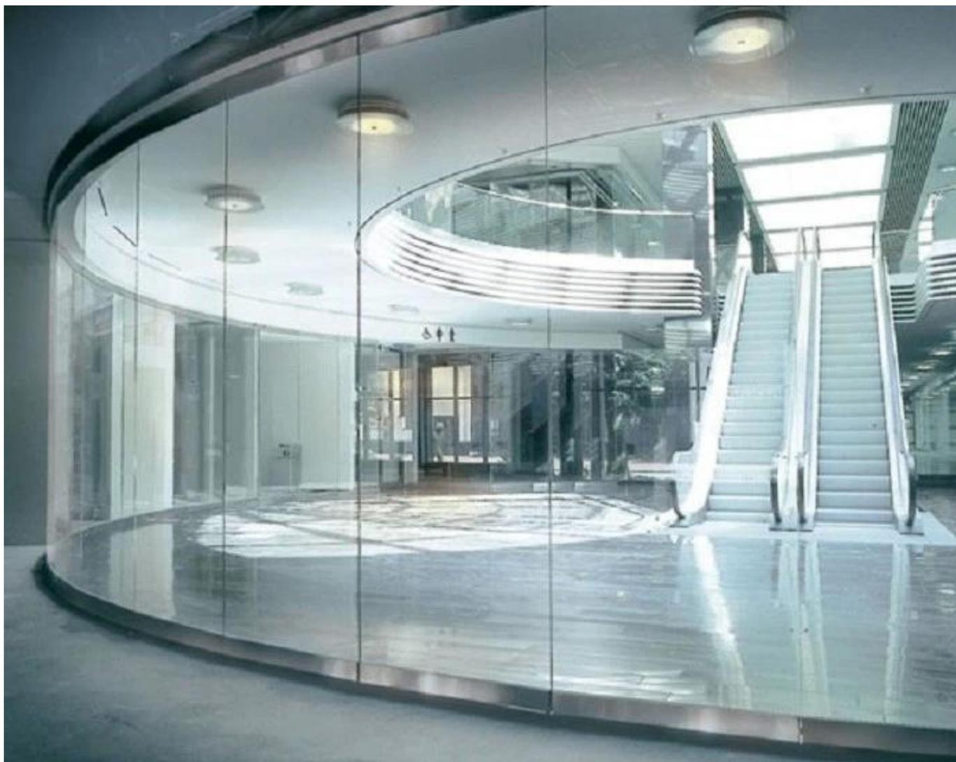
Parede de separação de vidro temperado de impressão digital de 12mm:
