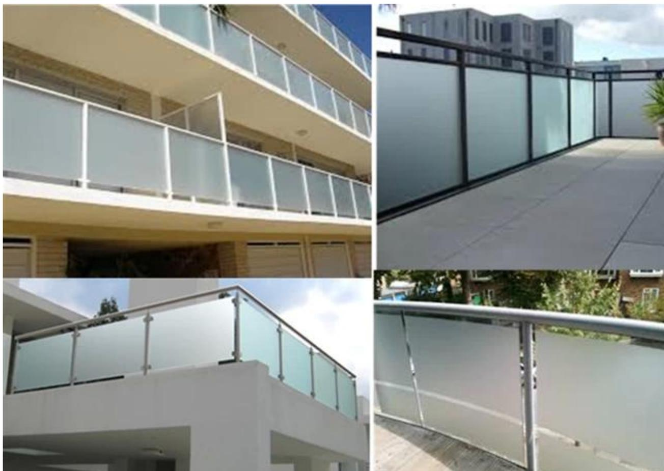
Ácido de três camadas gravado [vidro laminado temperado](#) para o chão
