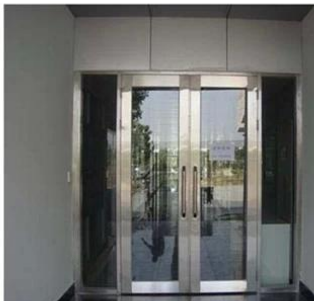
Vidro isolante resistente ao fogo usado para divisória de edifícios
