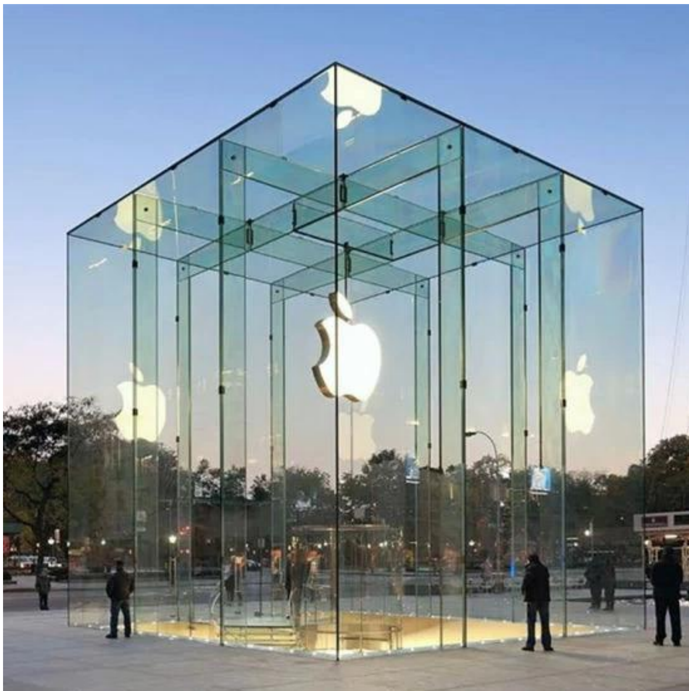
vidro tamanho jumbo - vidro do lobby com altura superior a 6 metros.
