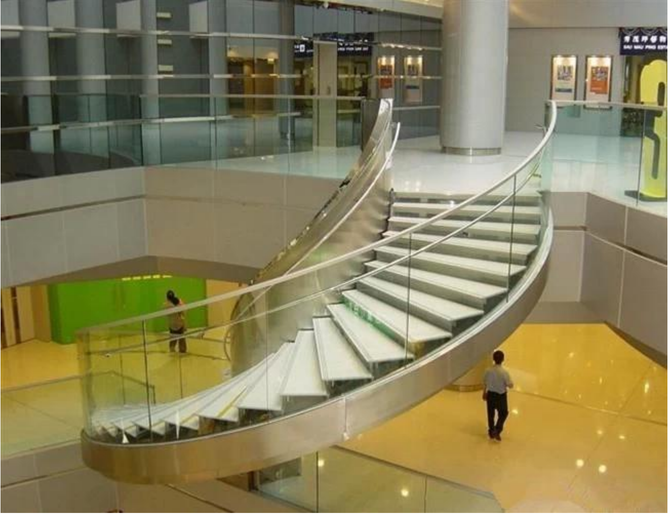
Küpeşte için 10 mm net kavisli temperli cam.
