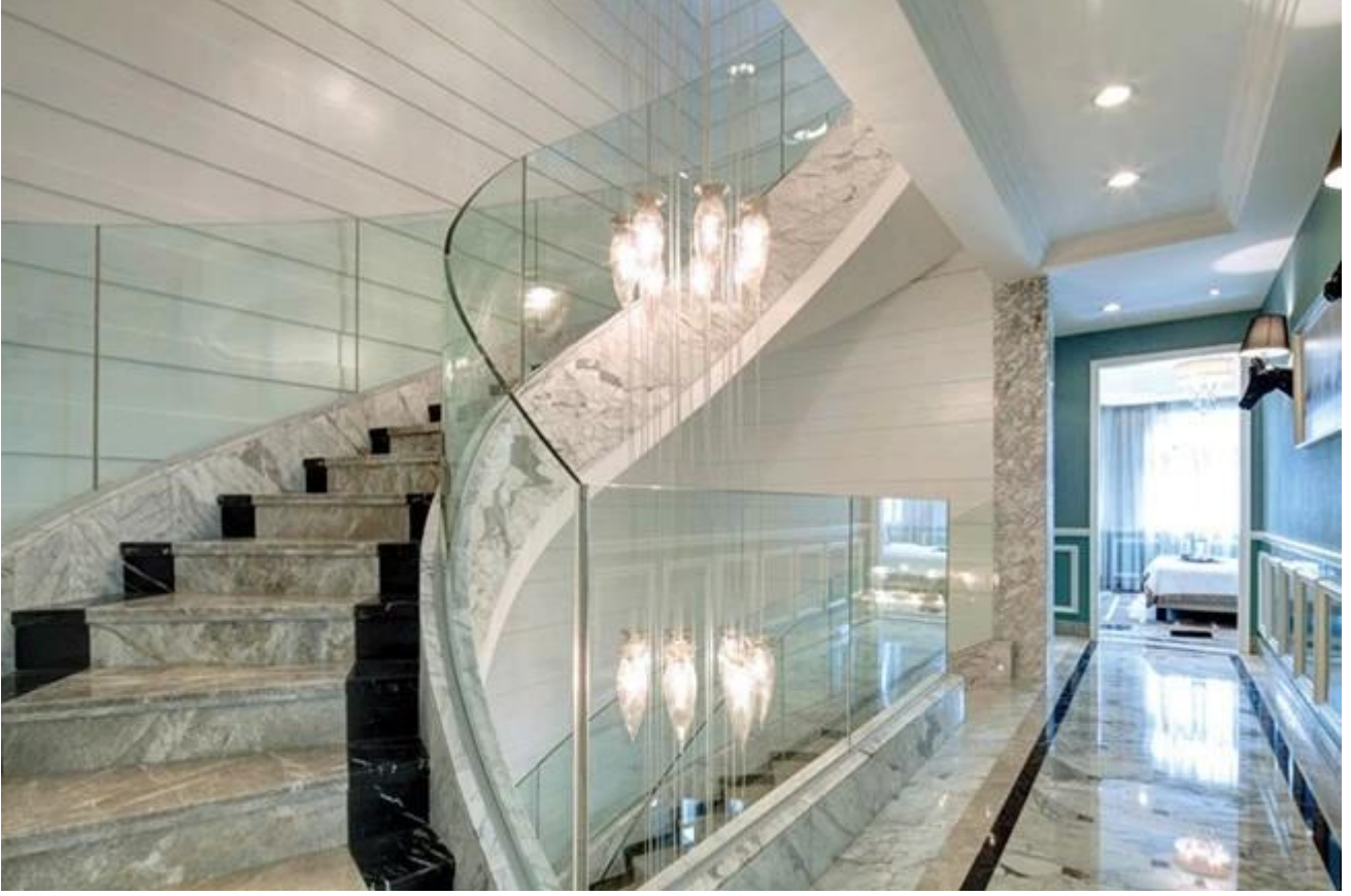
10mm sertleştirilmiş çerçevesiz korkuluk eğri cam.
