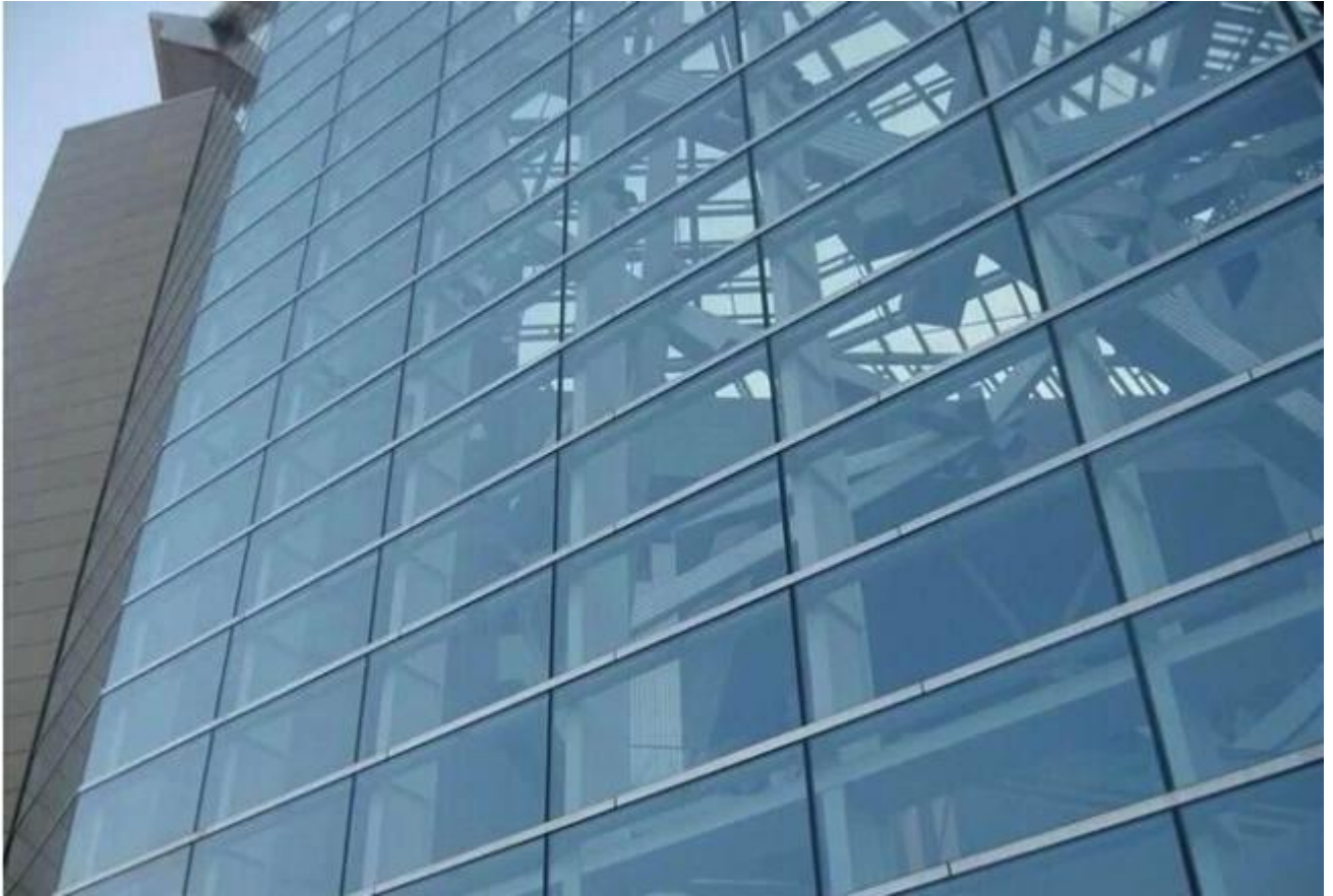
Perde duvar için kullanılan temperli lamine izolasyonlu cam:
