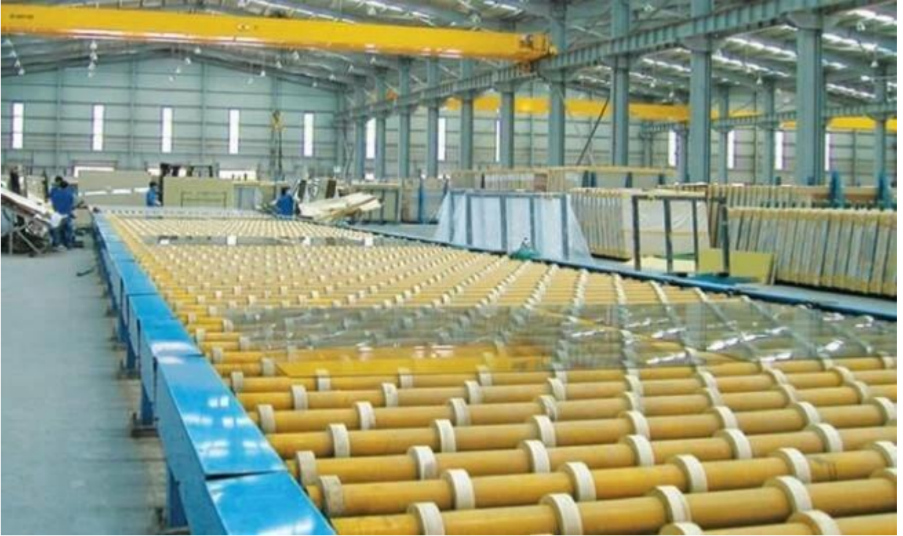
Float cam Üretim tesisi
