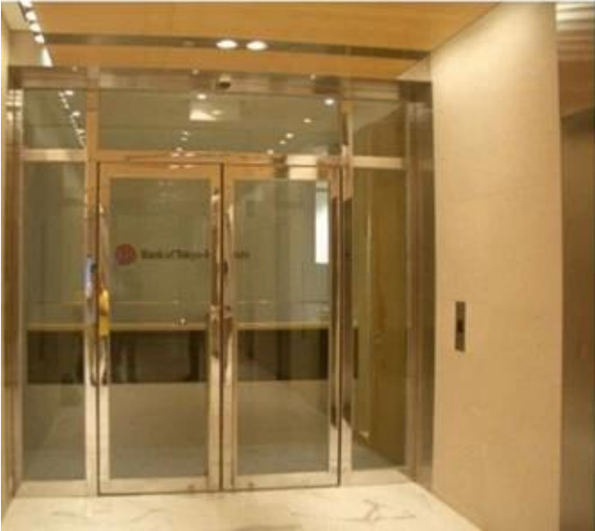
Bina bölmelerinde kullanılan yangına dayanıklı cam yalıtım
