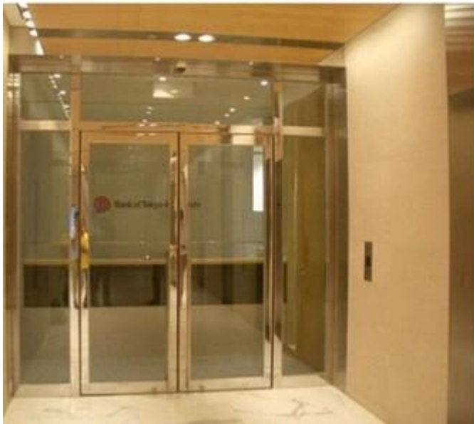
Kính cách điện chống cháy được sử dụng cho các tòa nhà phân vùng
